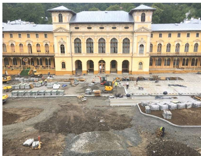
Krynicki deptak w trakcie prac remontowych FOT. ZAPOPRAZDZIE SP. Z O.O.
