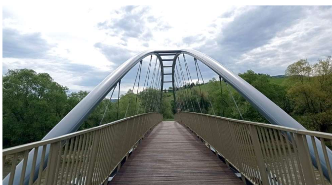
Kładka rowerowo-pieszna w Miliku FOT. ARCH. UMIGU MUSZYNA
