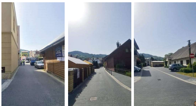
Wyremontowane ulice: Wąska, Krótka, Krzywa FOT. ARCH. UMIGU MUSZYNA
