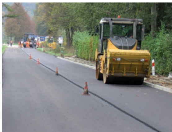
Nowa nawierzchnia asfaltowa przy ul. Lipowej wykonywana przez Zarząd Dróg Wojewódzkich w Krakowie
