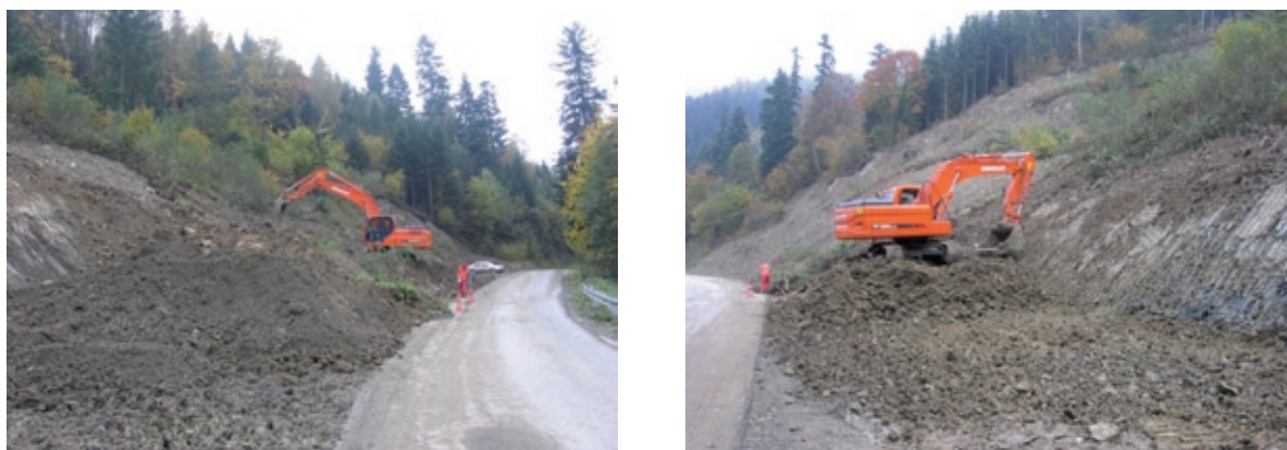
Stabilizacja osuwiska Lesik
