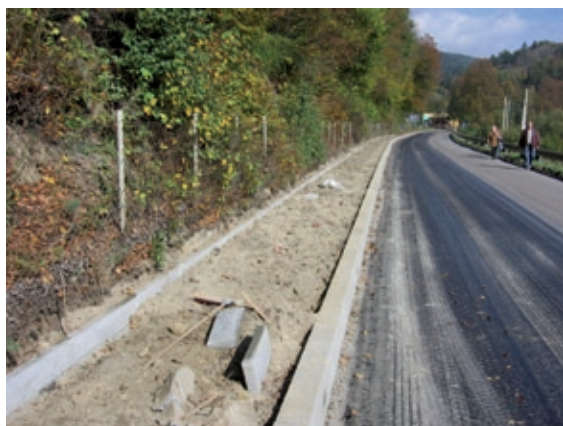
Budowa chodnika i oświetlenia ulicznego przy ul. Lipowej
