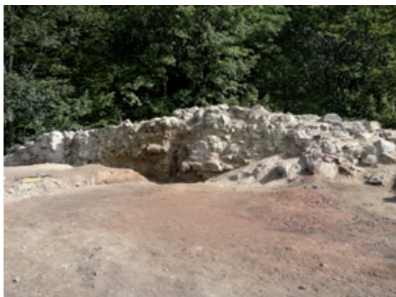
Wschodni mur obwodowy - widok od wnętrza zamku. Na pierwszym planie warstwa popożarowa.
