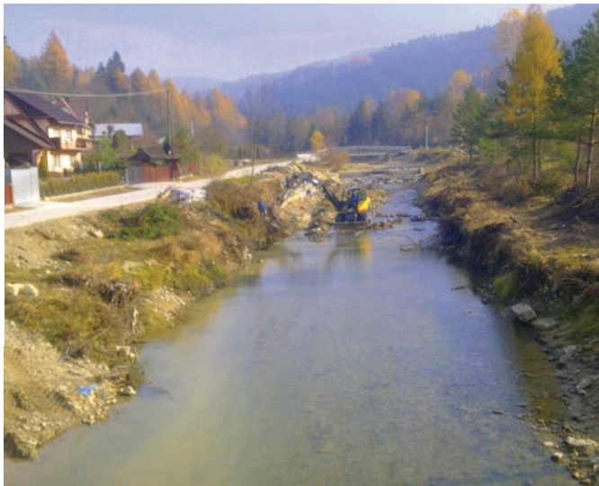
Stan początkowy. FOT. ARCH. PGK
