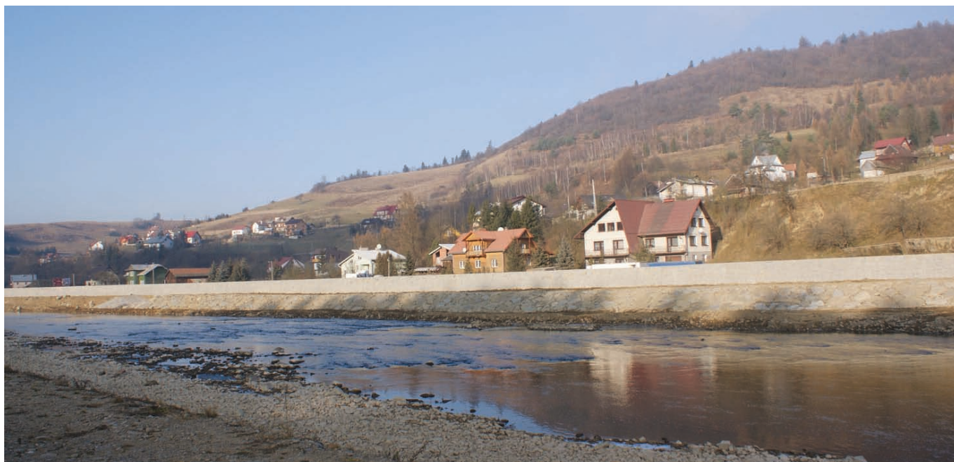
Prawobrzeżne obwałowanie na Popradzie. FOT. ARCH. UMIGU MUSZYNA
