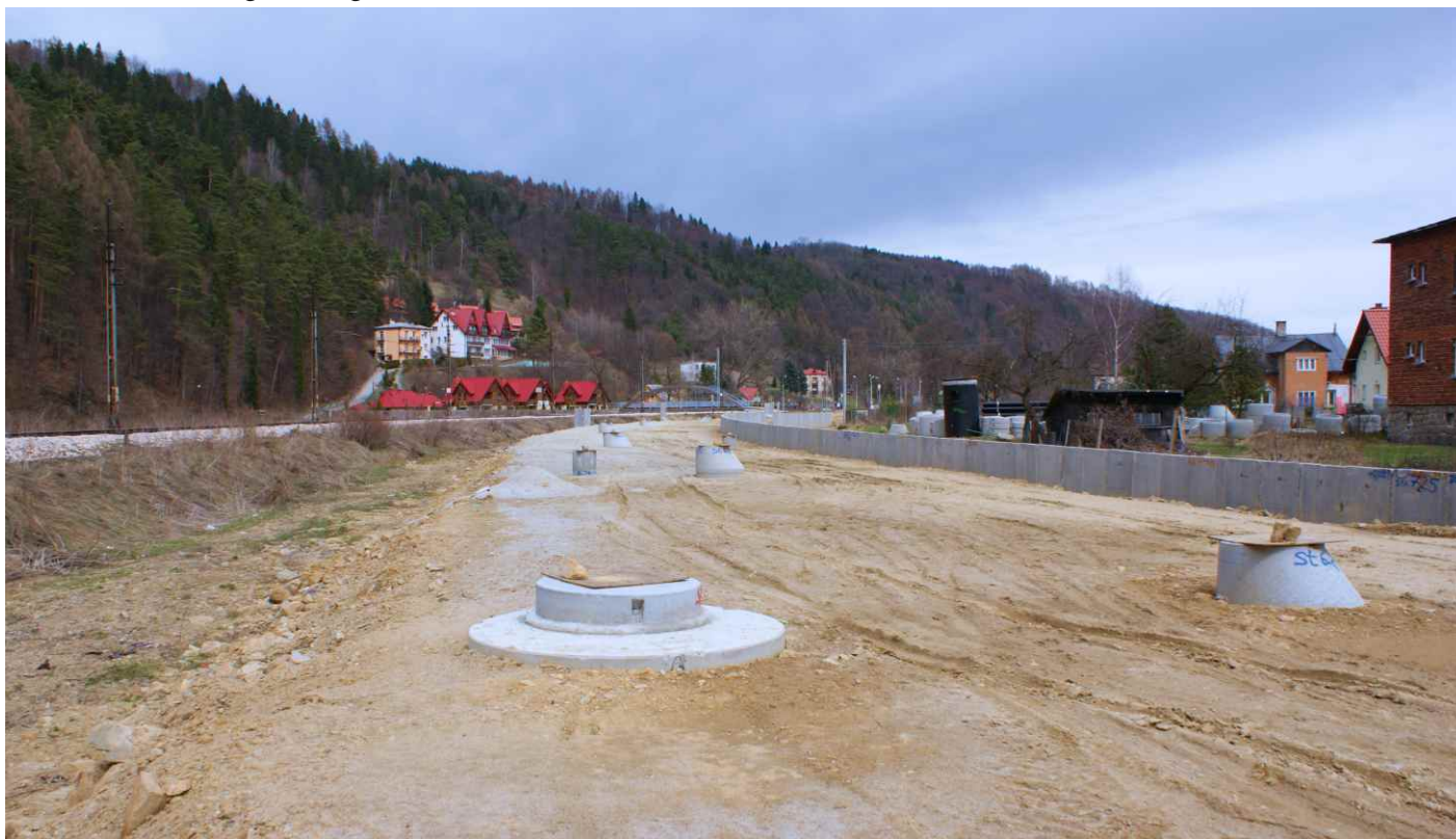
Plac budowy Obwodnicy Muszyny FOT. ARCH. UMIGU MUSZYNA
