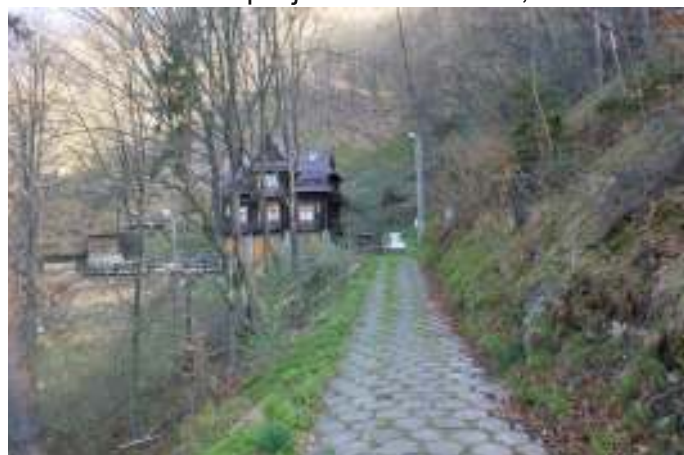
Teren przed inwestycją FOT. ARCH. UMIGU MUSZYNA
