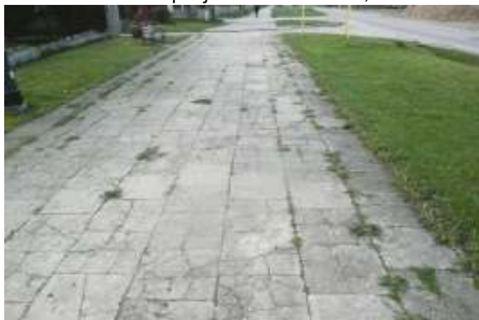
Teren przed inwestycją FOT. ARCH. UMIGU MUSZYNA
