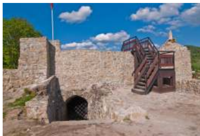
Teren po inwestycji FOT. ARCH. UMIGU MUSZYNA
