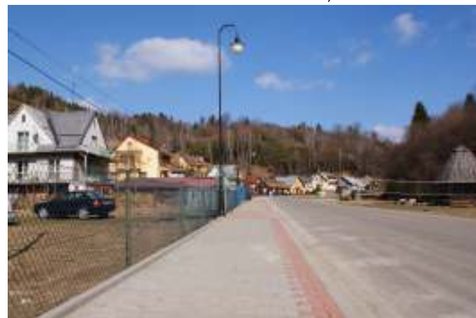
Teren po inwestycji FOT. ARCH. UMIGU MUSZYNA
