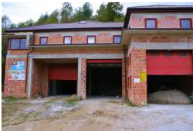
Remiza OSP Muszyna-Folwark w trakcie prac wykończeniowych FOT. ARCH. UMIGU MUSZYNA
