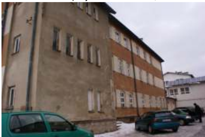
Budynek przed inwestycją FOT. ARCH. UMIGU MUSZYNA
