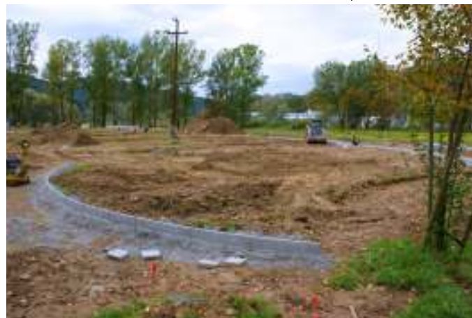
Teren w trakcie inwestycji FOT. ARCH. UMIGU MUSZYNA
