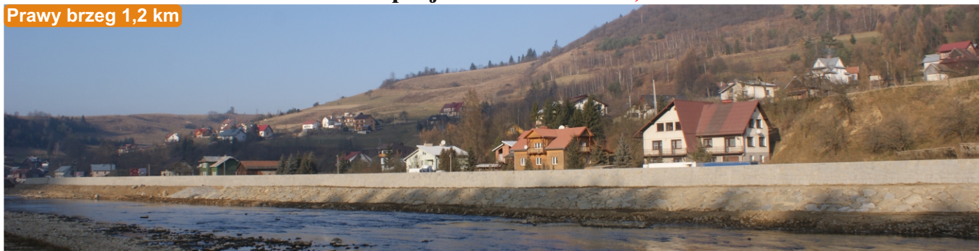
Wały przeciwpowodziowe na prawym brzegu Popradu wartość projektu - 8 600 000,00 zł
