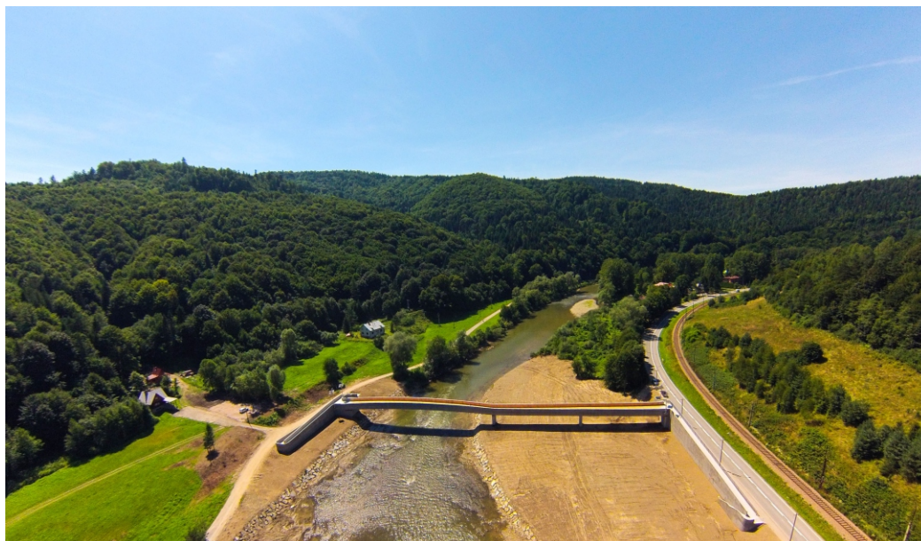
Nowa kładka rowerowo-pieszna w Żegiestowie FOT. WWW.SZLING.COM
