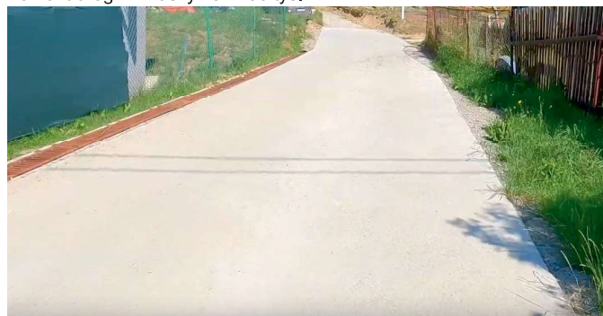
Remont drogi w Muszynie (Podgórna boczna) – 30 tys. zł
