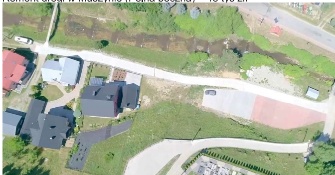
Remont drogi w Żegiestowie – 55 tys. zł
