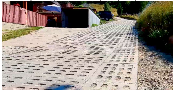
Remont drogi w Muszynie (Leśna Boczna) – 92 tys. zł
