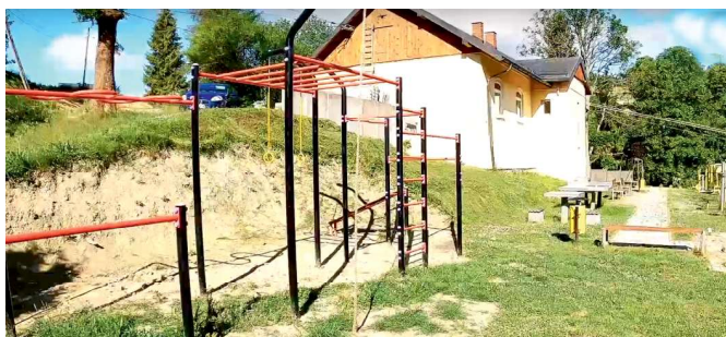
Wykonano prace wykończeniowe na placu zabaw przy świetlicy, zakup i montaż urządzeń oraz elementów małej architektury w Wojkowej - 18 tys. zł
