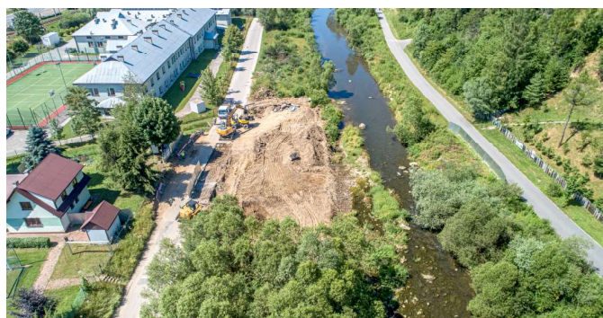
Ruszyły prace budowlane kładki rowerowej w Powroźniku - 2 mln zł FOT. M.OBIDOWSKI
