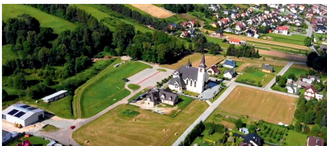
Remont drogi obok kościoła w Powroźniku - 113 tys. zł FOT. M.OBIDOWSKI
