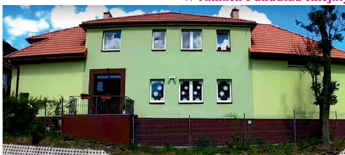
Remont w Szkole Podstawowej w Jastrzębiku – za kwotę 157 tys. zł
