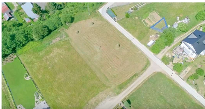
Modernizacja drogi ul. Rolanda boczna betonowa - 119 tys. zł
