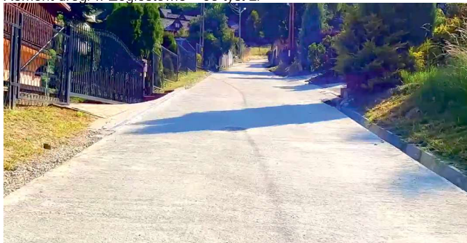
Remont drogi gminnej w Muszynie (Oгородowa boczna) I etap - 92 tys. zł
