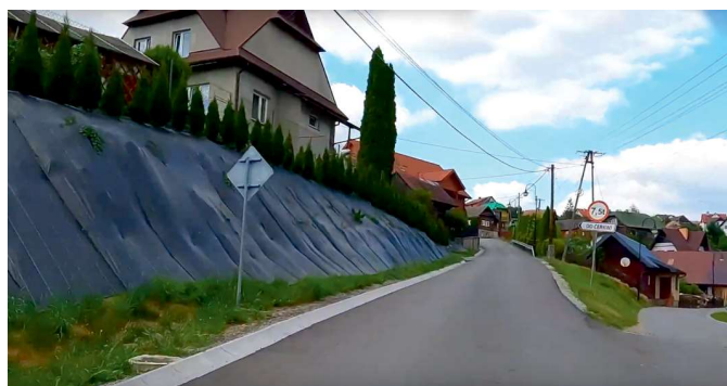
Remont drogi w Andrzejówce - 738 tys. zł FOT. UMIGU MUSZYNA
