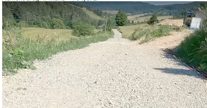
Remont drogi w Muszynie – 36 tys. zł
