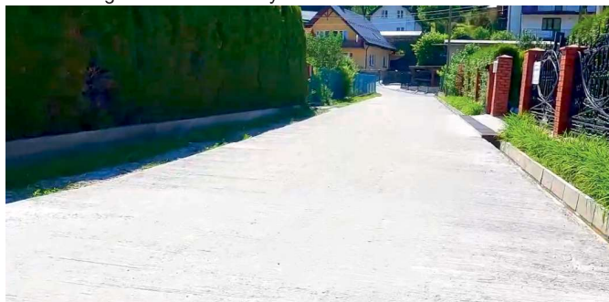
Remont drogi w Muszynie (ul. Grunwaldzka boczna) - 120 tys. zł FOT. UMIGU MUSZYNA
