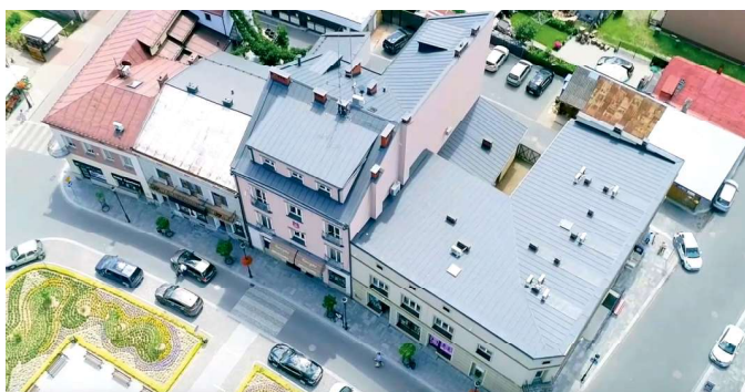
Remont dachu urzędu – 477 tys. zł FOT. M.OBIDOWSKI
