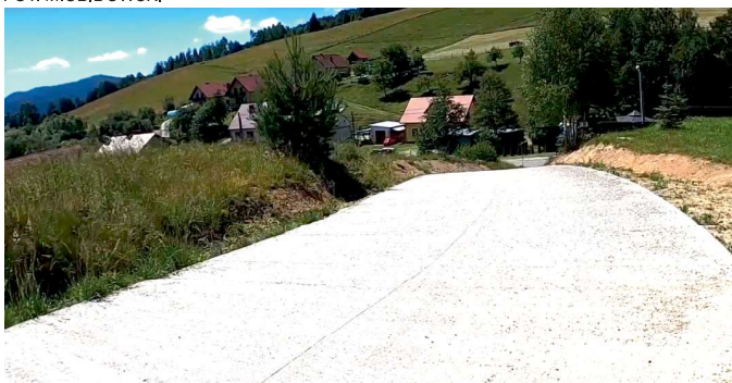
Remont drogi w Jastrzębiku - 77tys. zł FOT. UMIGU MUSZYNA
