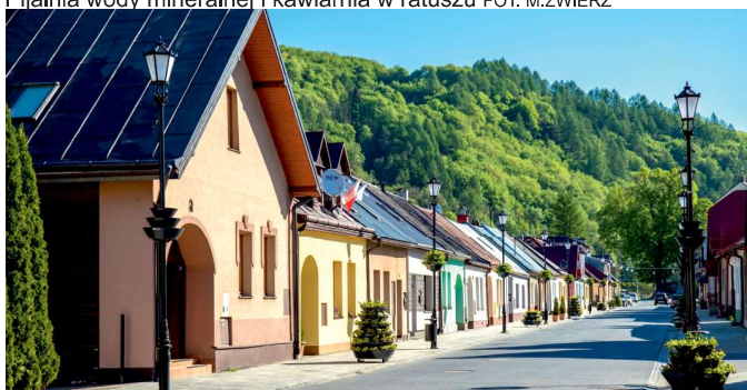
Ulica Kościelna po remoncie FOT. M.ZWIERZ
