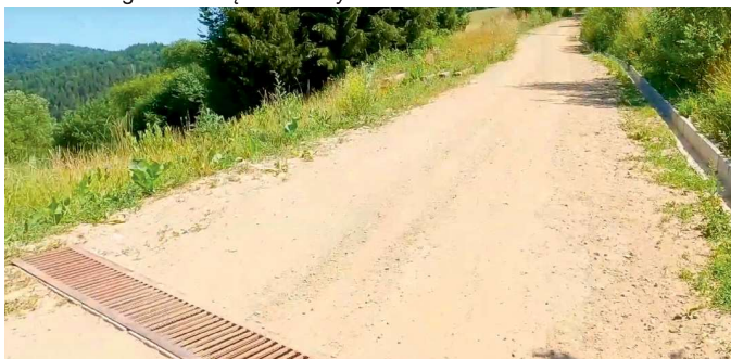
Remont drogi w Andrzejówce I etap - 58 tys. zł FOT. UMIGU MUSZYNA
