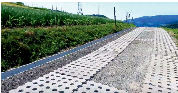
Modernizacja drogi dojazdowej w Złockiem – 51 tys. zł
