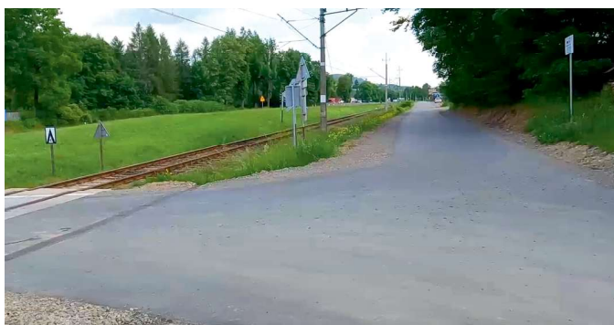
Remont drogi w Powroźniku Równia Krynicka – 577 tys. zł FOT. UMIGU MUSZYNA
