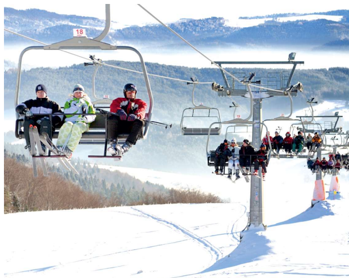
Wyciąg narciarski w Szczawniku FOT. ARCH. UMIGU MUSZYNA
