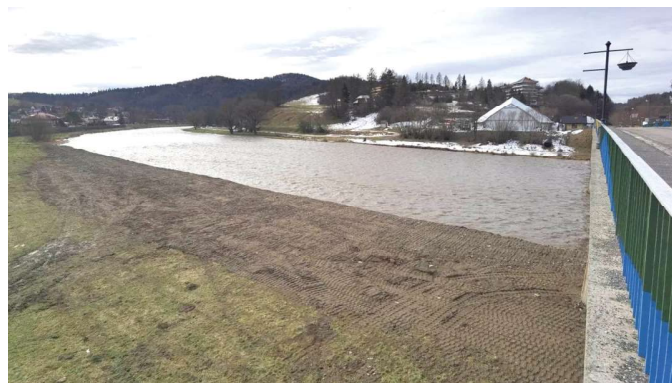
Teren po usunięciu łachy przy moście na Al. Zdrojową FOT. ARCH. UMIGU MUSZYNA
