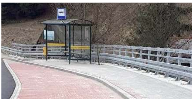
Nowa zatoka autobusowa w Miliku FOT. ARCH. UMIGU MUSZYNA
