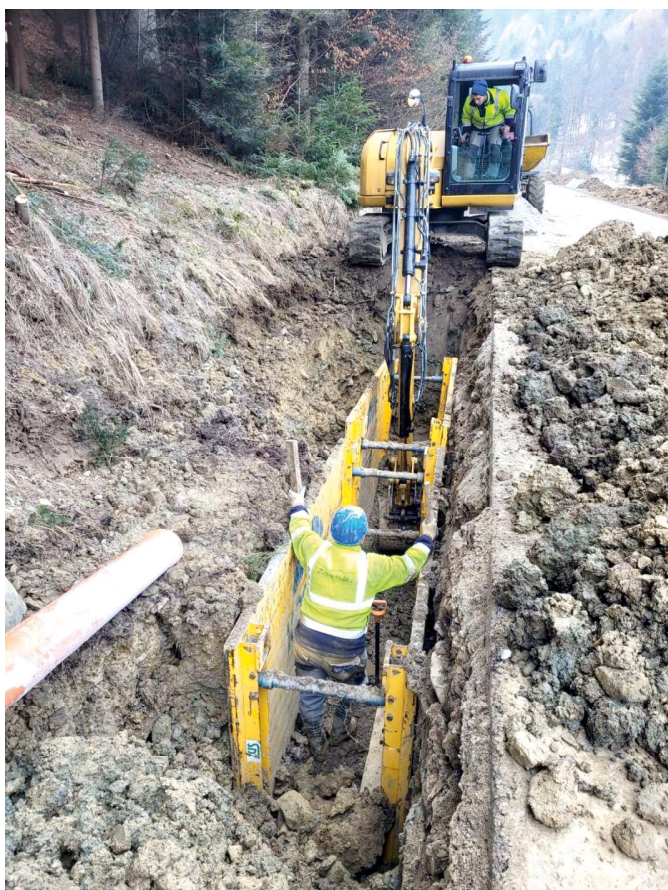
Prace przy kanalizacji w Wojkowej FOT. ZAOPRADZIE SP. Z O.O.
