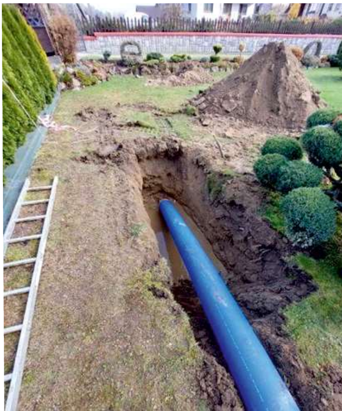
Przebudowa sieci wodociągowej przy ul. Grunwaldzkiej FOT. ZAOPRADZIE SP. Z O.O.
