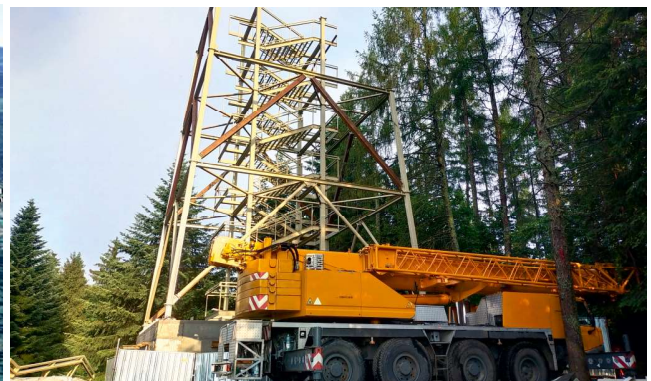
Budowa wieży widkowej na Malniku FOT. ARCH. UMIGU MUSZYNA
