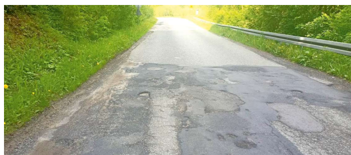
Fragment planowanej do remontu nawierzchni przy ul. Leśnej w ramach Funduszu Inicjatyw Lokalnych FOT. ARCH. UMIGU MUSZYNA
