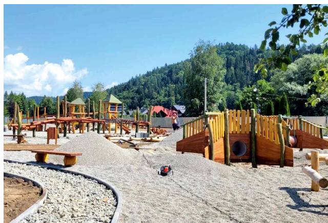
Realizowane prace w Parku Rodzinnym FOT. ARCH. UMIGU MUSZYNA
