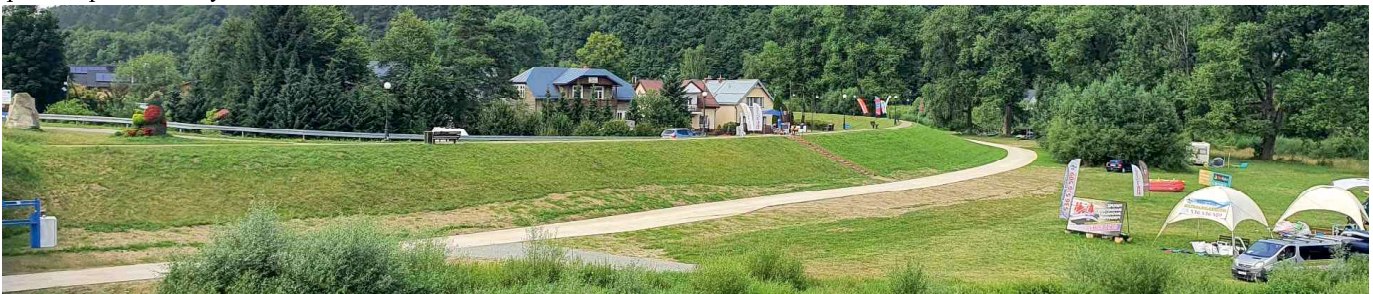
Nowa droga wzdłuż wałów przeciwpowodziowych - Al. Zdrojowa w Muszynie FOT. ARCH. UMIGU MUSZYNA
