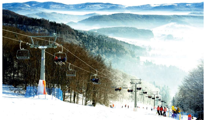
Wyciąg narciarski w Szczawniku FOT. ARCH. UMIGU MUSZYNA
