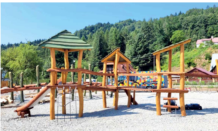
Realizowane prace w Parku Rodzinnym FOT. ARCH. UMIGU MUSZYNA
