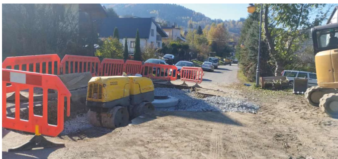
Prace związane z wykonaniem przyłączy wodociągowych w Powroźniku FOT. ARCH. UMIGU MUSZYNA
