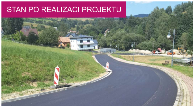
Remont drogi gminnej w Złockiem wartość zadania: 632 tys. zł
