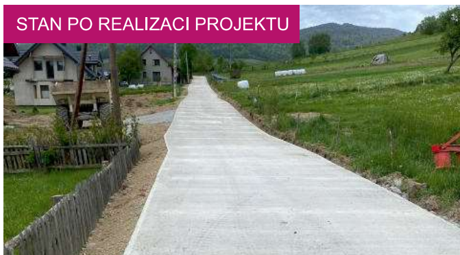
Remont drogi w Jastrzębiku wartość zadania: 189 tys. zł
