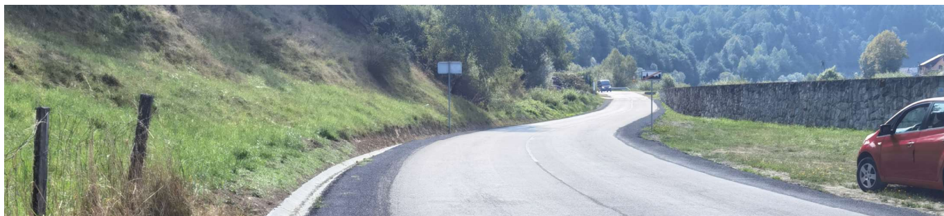
Droga przy ul. Leśnej po remoncie FOT. ARCH. UMIGU MUSZYNA
