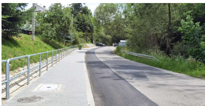
Remont drogi i chodnika w Złockiem FOT. ARCH. UMIGU MUSZYNA
