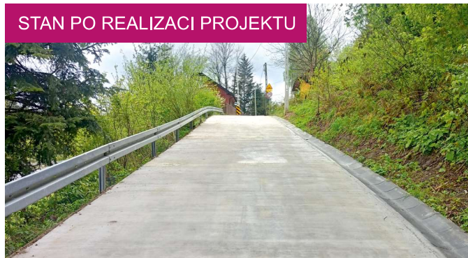
Remont drogi gminnej ul. Grunwaldzka boczna wartość zadania: 171 tys. zł
