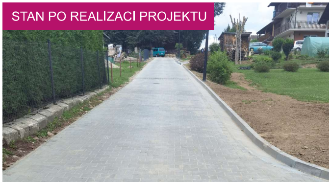
Remont drogi w Andrzejówce wartość zadania: 169 tys. zł
