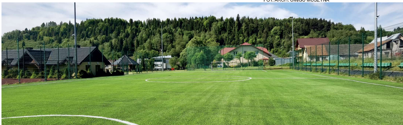
Orlik w Szczawniku po remoncie FOT. ARCH. UMIGU MUSZYNA
