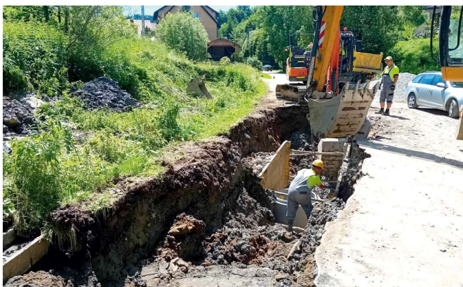
Prace budowlane sieci kanalizacji sanitarnej w Wojkowej FOT. ARCH. UMIGU MUSZYNA
