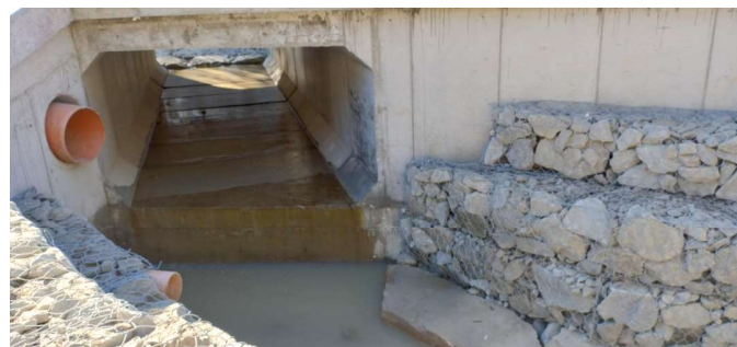
Jeden z przepustów drogowych w Wojkowej FOT. ARCH. UMIGU MUSZYNA
