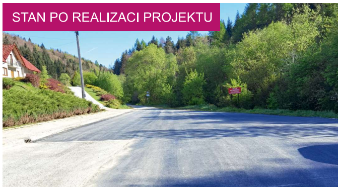
Remont zatoki autobusowej w Miliku wartość zadania: 176 tys. zł
