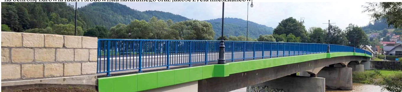
Wyremontowany most nad rzeką Poprad FOT. ARCH. UMIGU MUSZYNA
