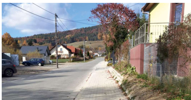
Remont drogi i chodnika w Jastrzębiku FOT. ARCH. UMIGU MUSZYNA
