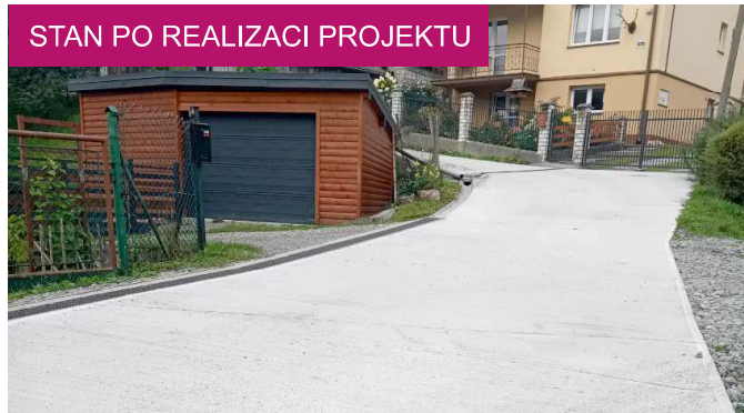
Remont drogi gminnej w Żegiestowie wartość zadania: 83 tys. zł
