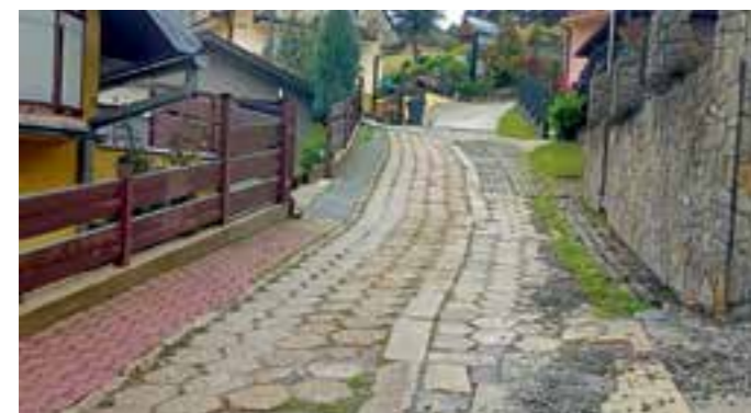
Muszyna ul. Polna (boczna) przed remontem FOT. ARCH. UMIGU MUSZYNA
