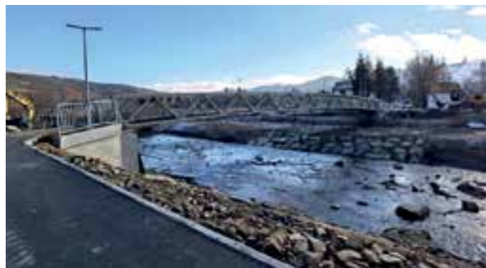
Kładka rowerowo-piesza w Powroźniku - oddanie do użytku wiosną 2023 r. wartość zadania: 2 336 227 zł. FOT. ARCH. UMIGU MUSZYNA
