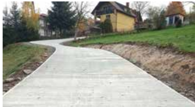
Droga gminna w Żegiestowie po remoncie wartość zadania: 149 000 zł. FOT. ARCH. UMIGU MUSZYNA
