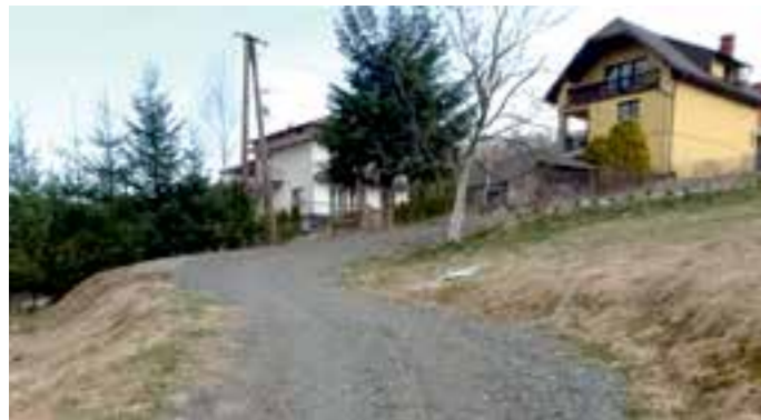
Droga gminna w Żegiestowie przed remontem FOT. ARCH. UMIGU MUSZYNA
