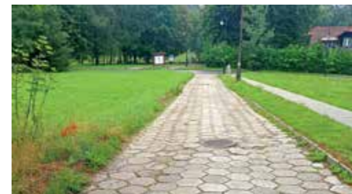
Muszyna ul. Zielona (boczna) przed modernizacją FOT. ARCH. UMIGU MUSZYNA
