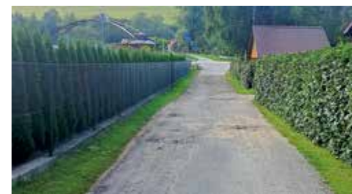
Droga gminna w Miliku (koło rozlewni) przed remontem FOT. ARCH. UMIGU MUSZYNA
