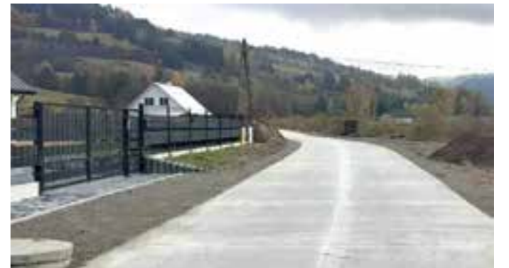
Droga gminna w Powroźniku etap I po remoncie wartość zadania: 227 840 zł. FOT. ARCH. UMIGU MUSZYNA
