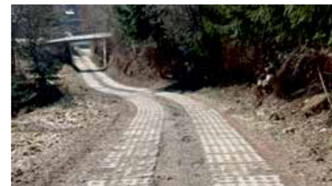
Muszyna - ul. Leśna (boczna) przed remontem FOT. ARCH. UMIGU MUSZYNA
