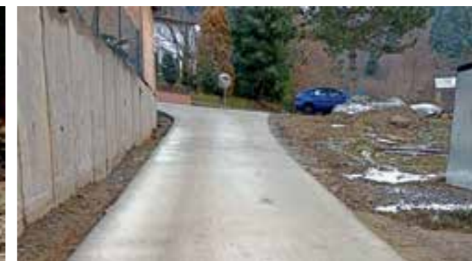
Muszyna ul. Leśna (boczna) po remoncie wartość zadania: 160 000 zł. FOT. ARCH. UMIGU MUSZYNA
