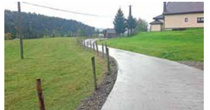
Droga wewnętrzna w Andrzejówce po remoncie wartość zadania: 158 872 zł. FOT. ARCH. UMIGU MUSZYNA
