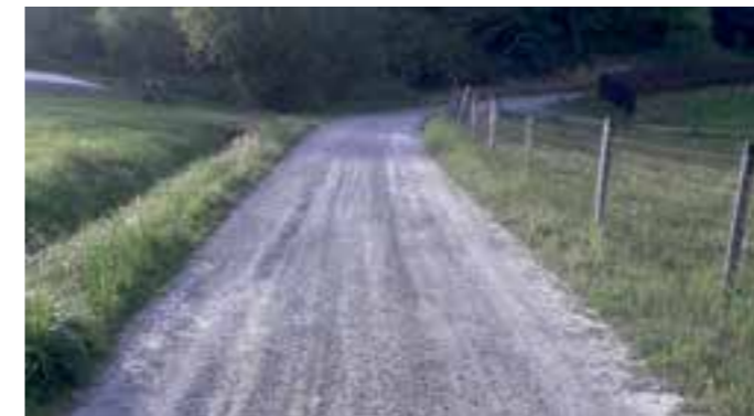
Droga wewnętrzna w Andrzejówce przed remontem FOT. ARCH. UMIGU MUSZYNA
