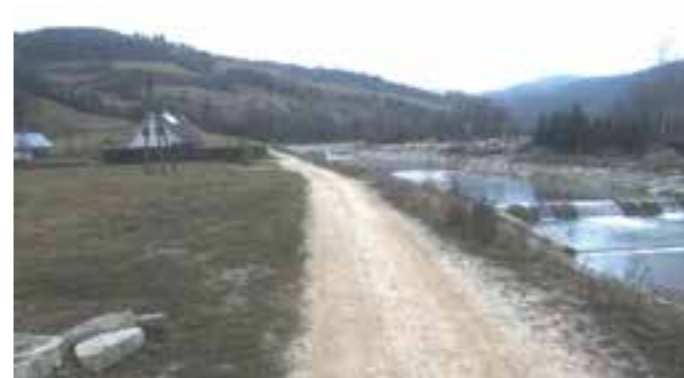
Droga gminna w Powroźniku przed remontem FOT. ARCH. UMIGU MUSZYNA
