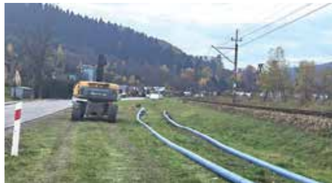
Budowa sieci wodociągowej w Powroźniku - projekt w trakcie realizacji wartość zadania: 6 761 595 zł. FOT. ARCH. UMIGU MUSZYNA
