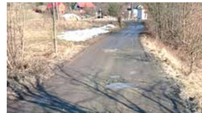
Muszyna - droga na Wesolówkę przed remontem FOT. ARCH. UMIGU MUSZYNA
