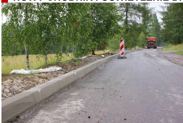
Remont chodnika w stronę Jasieńczyka
