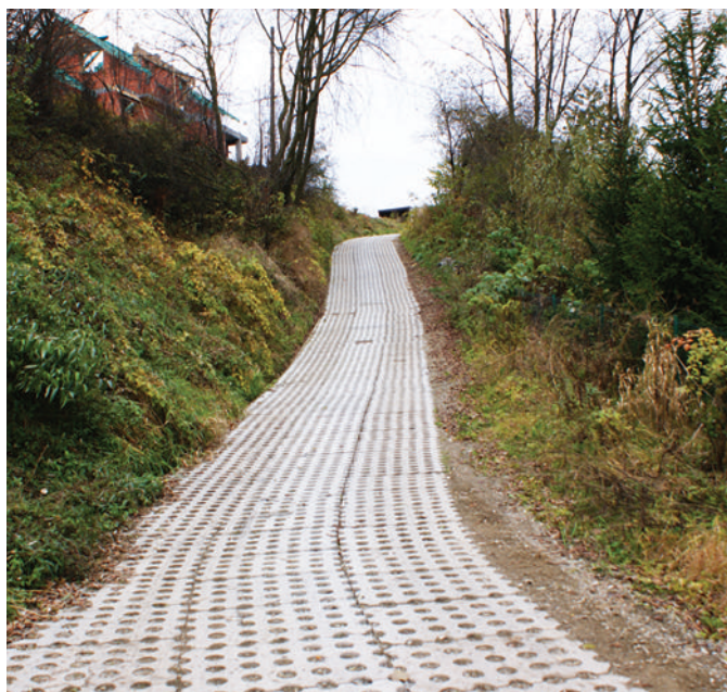
Droga boczna od ul. Rolanda po modernizacji. FOT. ARCH. UMIG MUSZYNA
