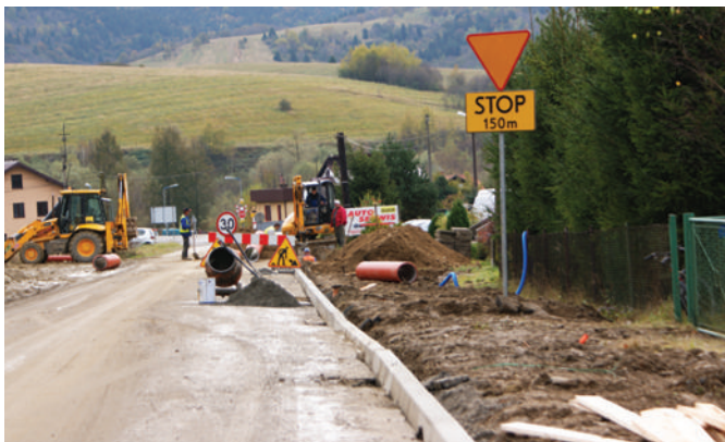
Prace budowlane w Miliku FOT. ARCH. UMIGU MUSZYNA
