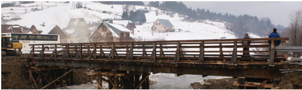
Tymczasowy most w stronę Jastrzębika FOT. ARCH. UMIGU MUSZYNA
