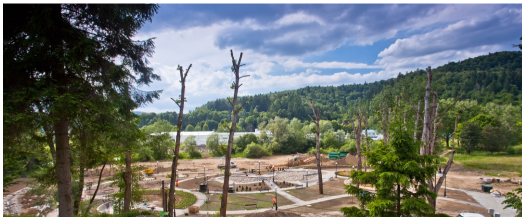
Stawy rekreacyjne na Zapopradziu - inwestycja w trakcie realizacji FOT. KONRAD ROGOZIŃSKI
