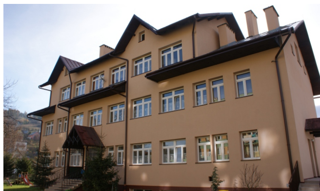
Budynek przedszkola w Muszynie po termomodernizacji FOT. ARCH. UMIGU MUSZYNA
