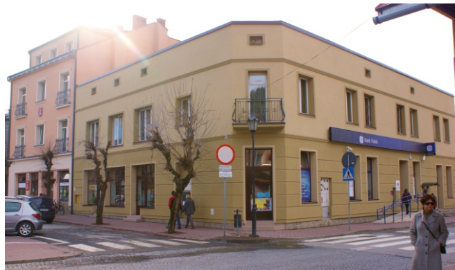
Budynek urzędu po termomodernizacji FOT. ARCH. UMIGU MUSZYNA
