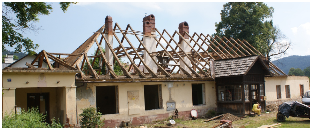
Dwór Starostów w Muszynie w trakcie odbudowy FOT. ARCH. UMIGU MUSZYNA
