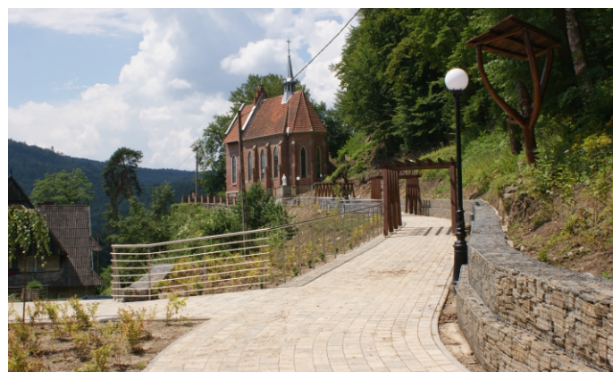
Deptak w Żegiestowie - inwestycja w trakcie realizacji FOT. ARCH. UMIGU MUSZYNA
