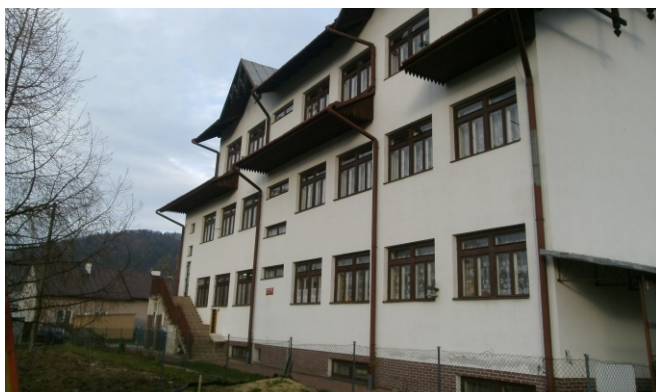
Budynek przedszkola w Muszynie przed termomodernizacją FOT. ARCH. UMIGU MUSZYNA
