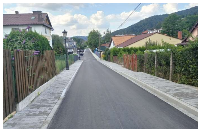
Ulica Zefirka po remoncie FOT. ARCH. UMIGU MUSZYNA
