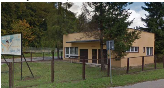
Przepompownia przy ul. Lipowej przed inwestycją FOT. ARCH. PGK
