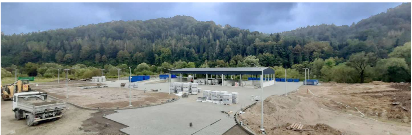
Prace budowlane na terenie Punktu Selektywnej Zbiórki Odpadów przy ul. Lipowej FOT. ARCH. PGK
