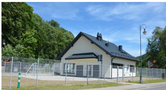
Przepompownia przy ul. Lipowej po inwestycji FOT. ARCH. PGK
