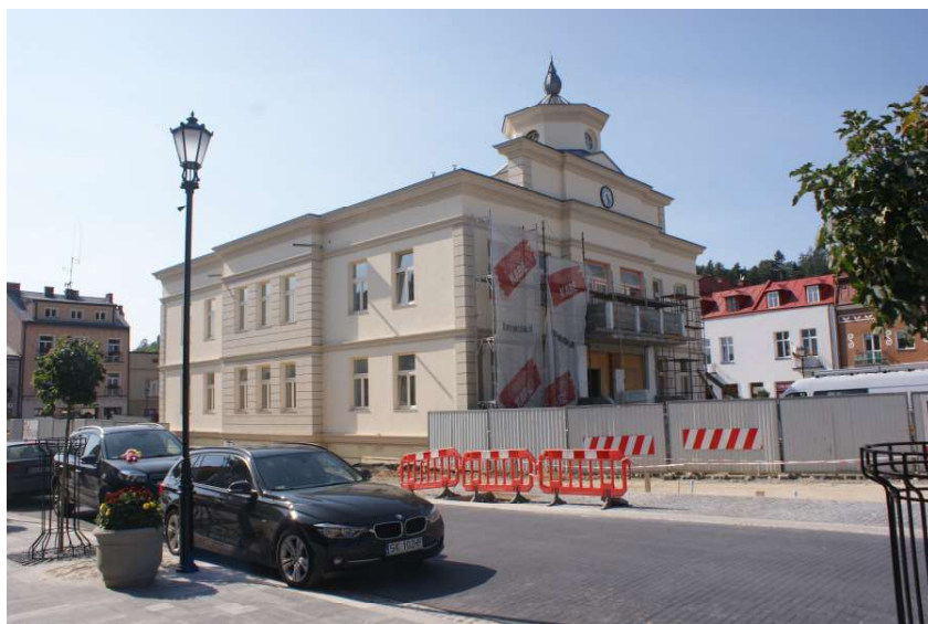
Ratusz w końcowej fazie budowy FOT. ARCH. UMIGU MUSZYNA
