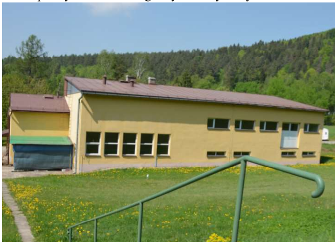
SUW „Jasieńczyk” przed inwestycją FOT. ARCH. PGK
