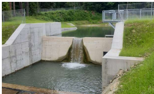
Ujęcie „Jasieńczyk” po inwestycji FOT.ARCH. PGK
