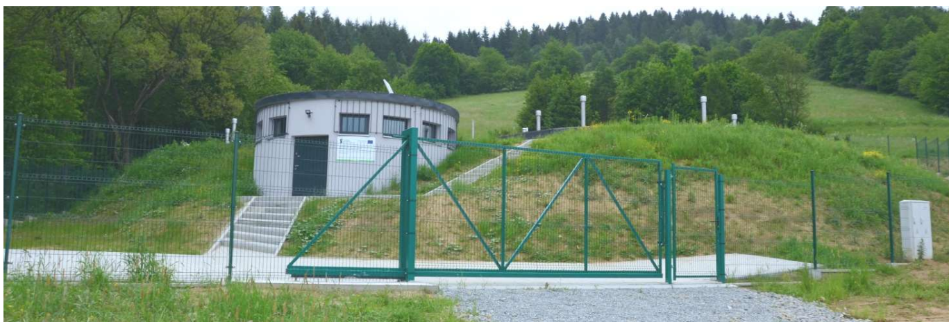
Wyremontowane zbiorniki wyrównawcze „Malnik” FOT. ARCH. PGK
