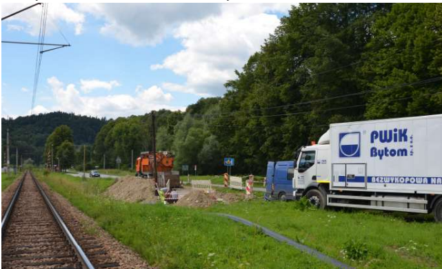
Prace remontowe sieci kanalizacji sanitarnej FOT. ARCH. PGK
