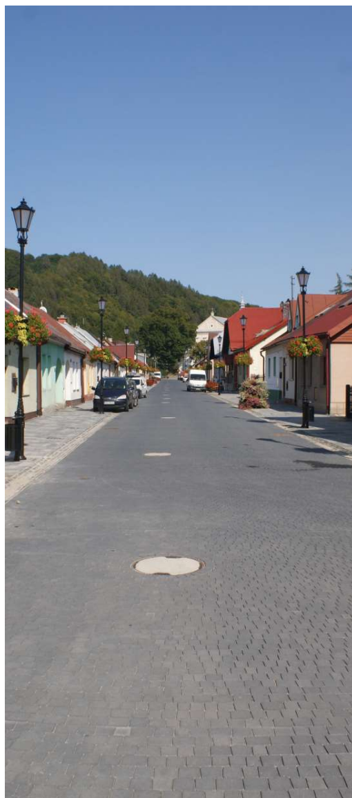
Ulica Kościelna po rewitalizacji FOT. ARCH. UMIGU MUSZYNA
