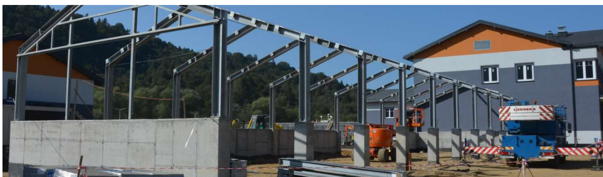
Wiata garażowa w trakcie budowy FOT.ARCH. PGK
