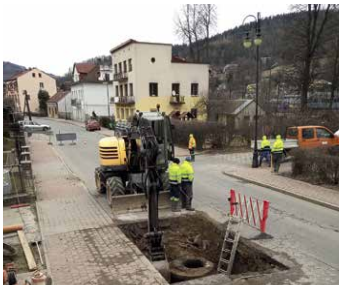
Prace przy ul. Piłsudskiego FOT. PGK MUSZYNA
