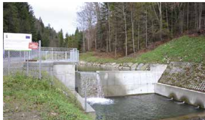
Ujęcie wody „Szczawnik” po realizacji zadania FOT. PGK MUSZYNA
