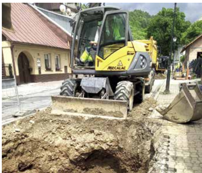
Prace przy ul. Kościelnej FOT. PGK MUSZYNA
