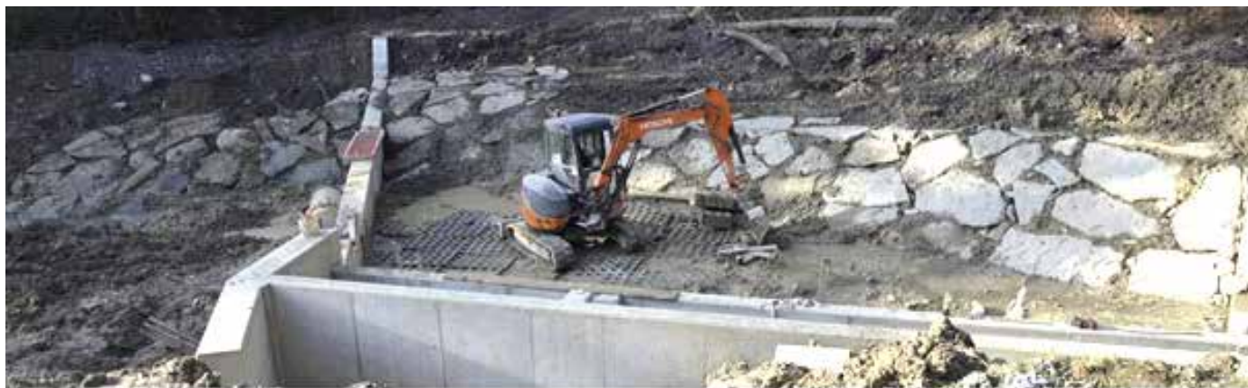
Prace przy ujęciu wody „Jasieńczyk” FOT. PGK MUSZYNA
