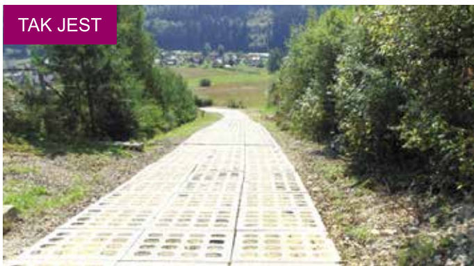
Budowa miejsc postojowych dla samochodów osobowych wartość zadania: 42 705 zł
